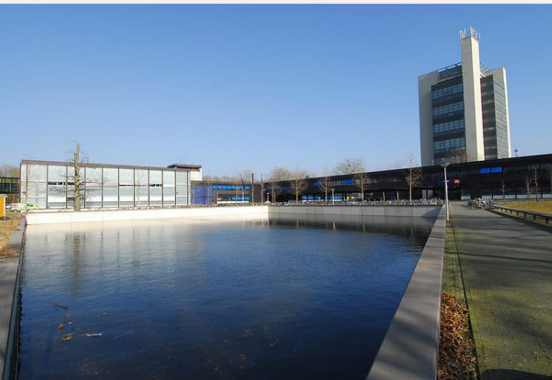
Vijver die zorgt voor koeling van de labs in omliggende gebouwen
