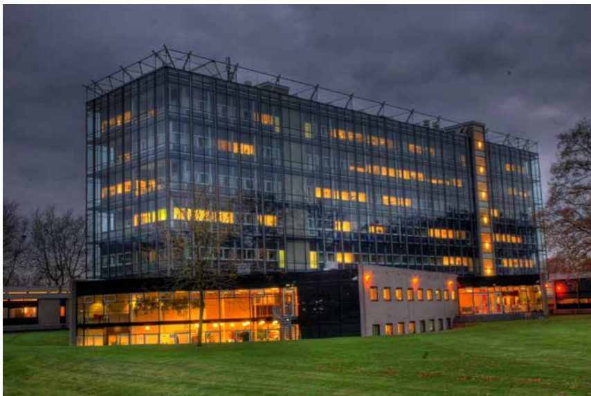
orgineel ontwerp (1967): transparante plint met zicht op de omgeving volumes die deels in de glazen plint steken intermediären verbinden groot volume en kleine volumes
