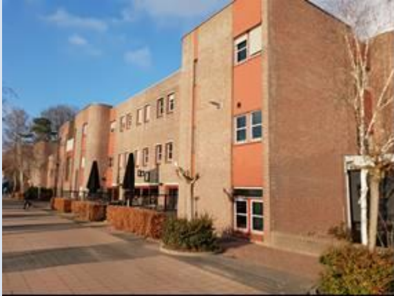
Figuur 2.1 Foto's gebouw
